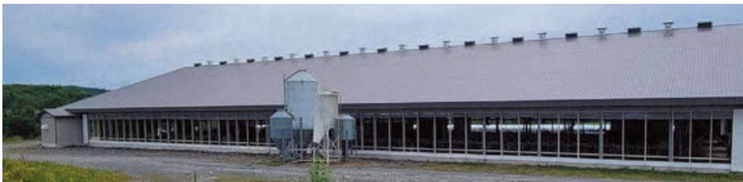
Les installations de la Ferme Counard bénéficient d'une ventilation naturelle.
