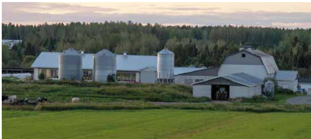
La vacherie et l'étable à taures de la Ferme Harricana inc. ont été rénovées en stabulation libre pour les vaches alors qu'un bâtiment en ventilation naturelle a été construit pour les sujets de remplacement.
