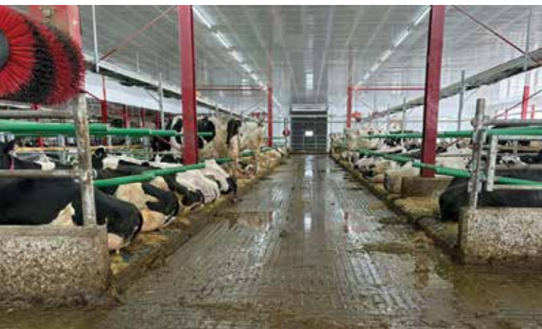
L'orientation, la profondeur, la largeur, l'espacement des rainures ainsi que la texture de la surface entre celles-ci influencent directement la traction, la croissance des sabots, la durabilité du plancher et la facilité d'entretien. Crédit photo : Traction Plus
